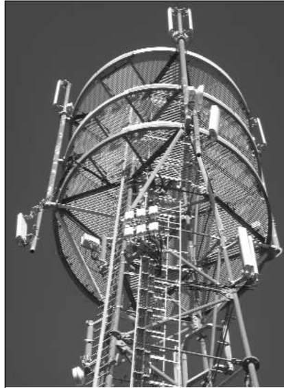
Abb. 1: Je dichter das Netz an Basisstationsendern, desto geringer sind die Sendeleistungen der Sender selbst, aber auch die der Mobiltelefone.
